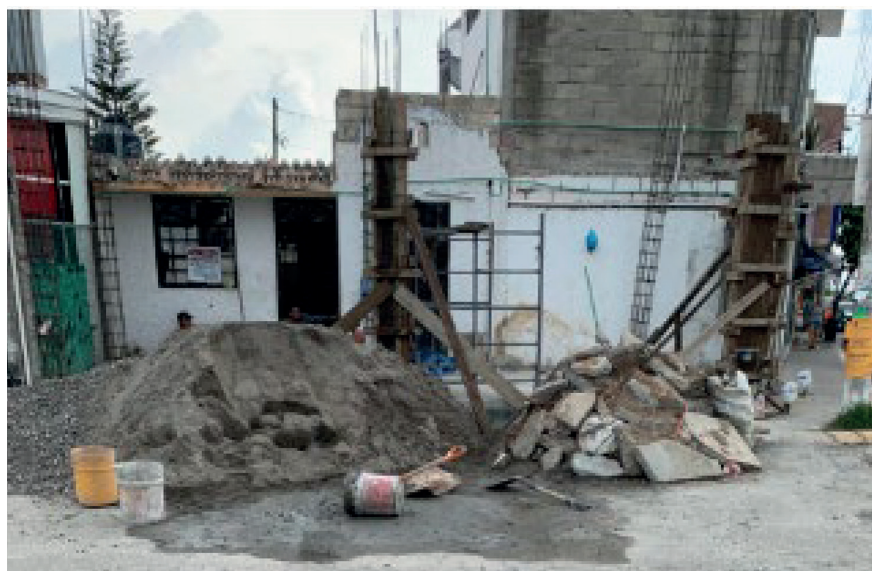
IMAGEN 4. REMODELACIÓN DE CASA HABITACIÓN A LOCAL COMERCIAL.
